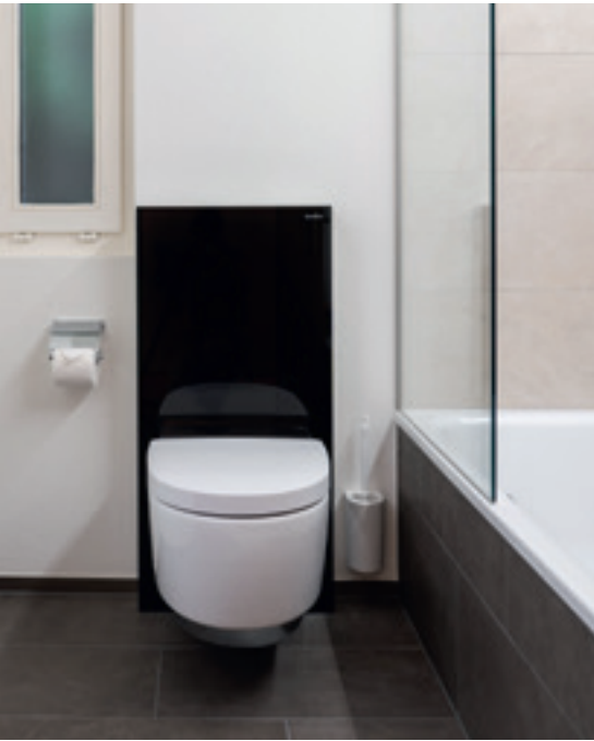
JÄLKEEN Asennus Geberit Monolith -moduulilla
