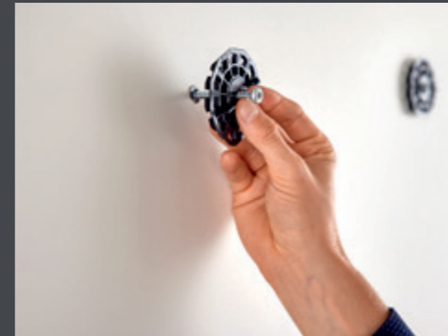
↑ Kiinnitä Geberitin seinäkiinnityspidike.
